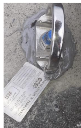
Registro fotográfico instalación Línea vida y anclajes.
