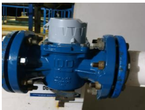
Registro fotográfico Macromedidor 4" y Válvula.
