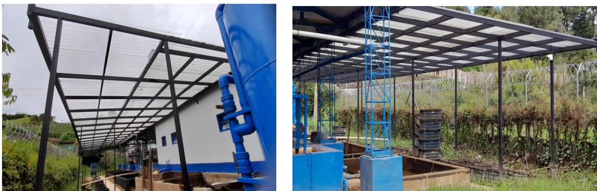
Registro fotográfico de Cubierta lechos de secado.
