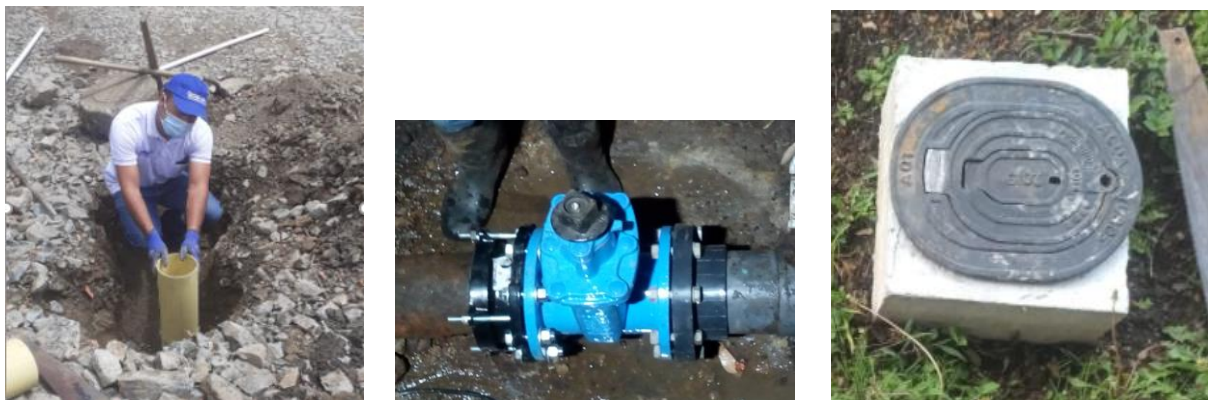
Registro fotográfico Cambio de válvulas.
