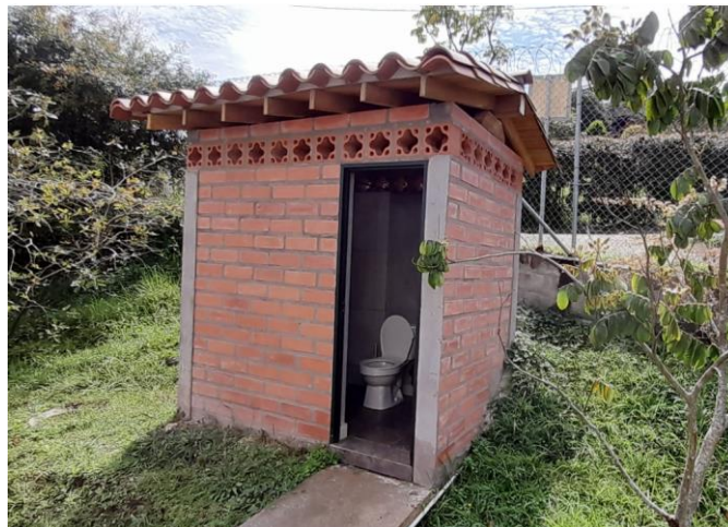
Registro fotográfico unidad sanitaria.
