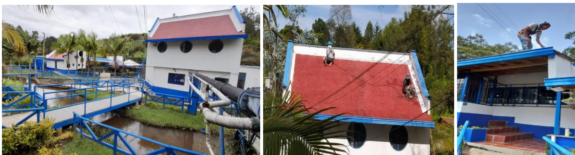
Registro fotográfico de pintura planta potable.
