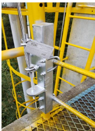
Registro fotográfico instalación Línea vida y anclajes.
