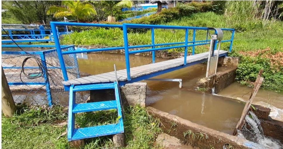
Registro fotográfico puente para operación compuerta.
