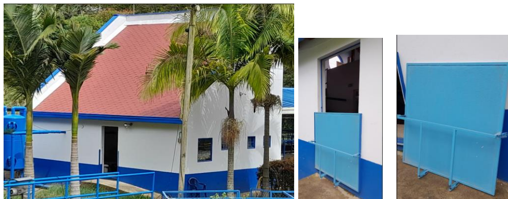
Registro fotográfico compuertas de control inundación.
