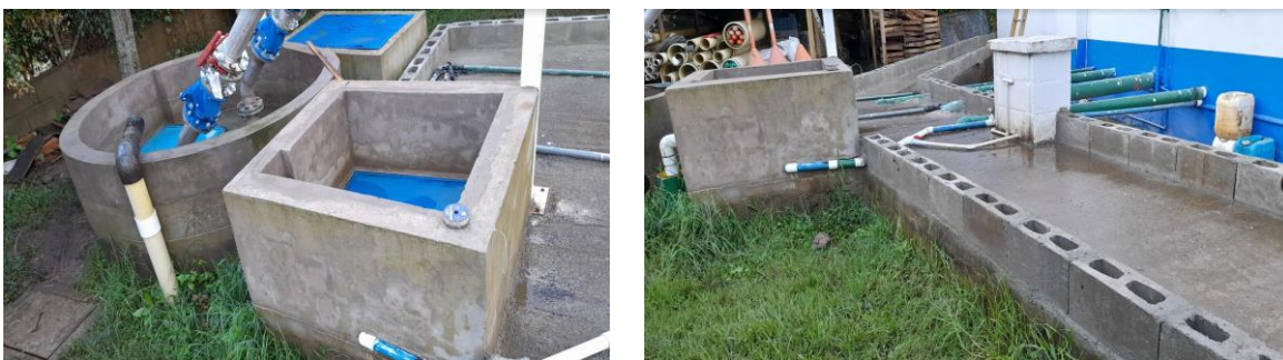
Registro fotográfico elevación muros en Tanque de Cloración.
