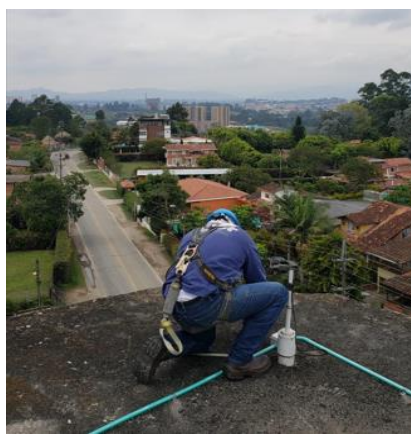
Registro fotográfico instalación Línea vida y anclajes.
