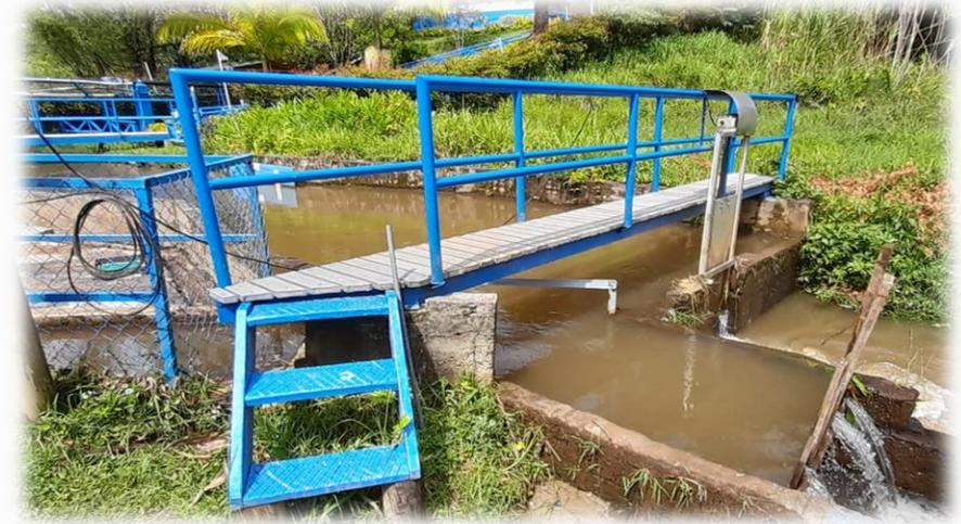
Instalación de puente metálico para operación compuerta de control de la Bocatoma.
