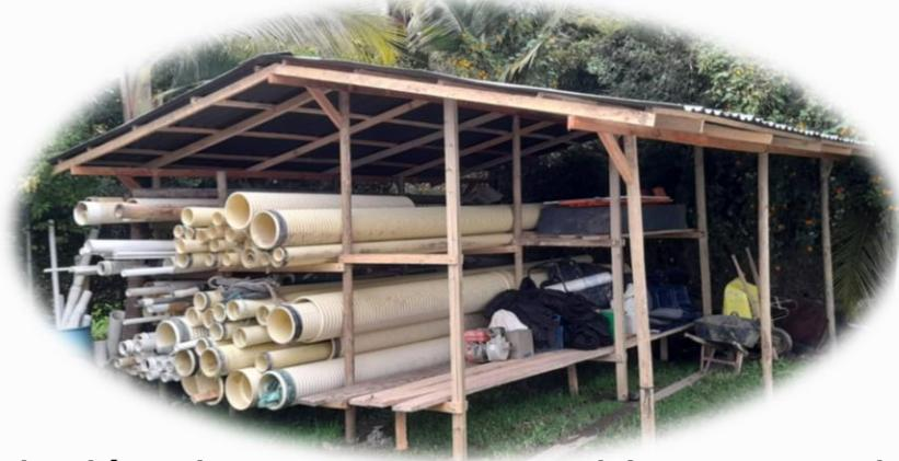
Instalación de una caseta cubierta para la protección y almacenamiento de tubería, materiales, equipos y accesorios en la planta potable PTAP.
