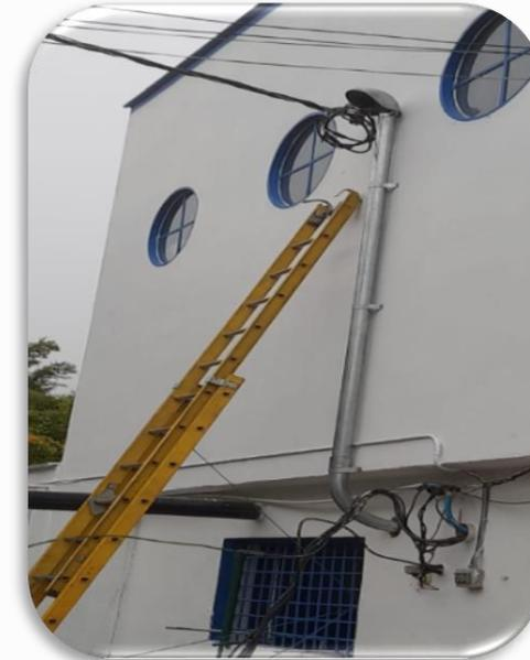
Cambio de la Acometida eléctrica de 7500 KVA desde el transformador hasta la estación de Bombeo de la PTAP.
