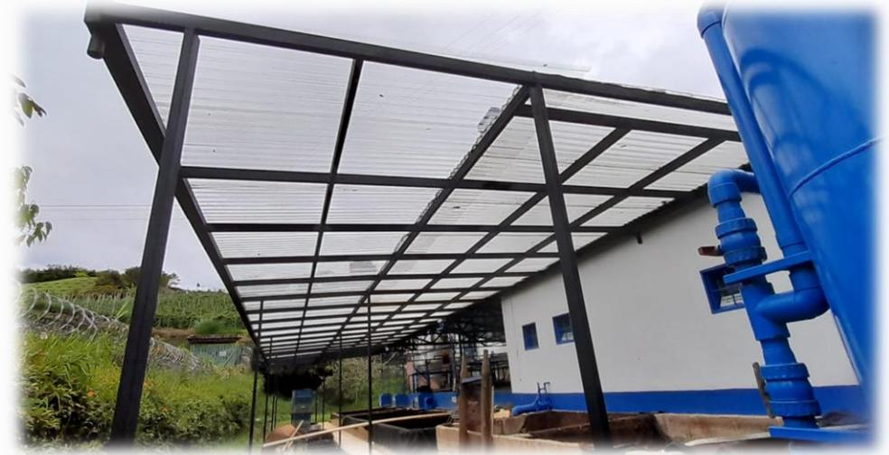
Ampliación de la cubierta con estructura metálica y teja de policarbonato para el procesamiento y secado de lodos provenientes de la PTAP.
