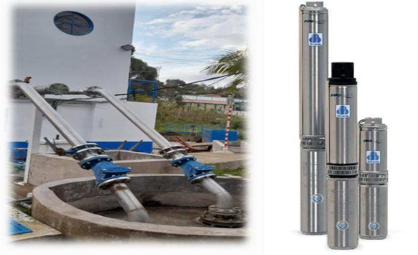
Cambio de bomba franklin de 18 litros por segundo, de la estación del bombeo hacia el Alto de la Virgen .
