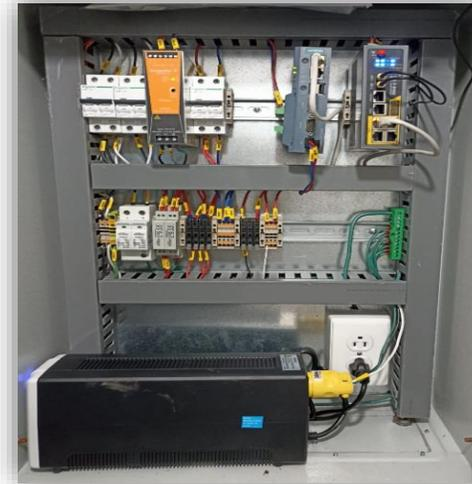
**Instalación del sistema de medición de nivel del tanque elevado Alto de la Virgen, con telemetría vía Web, para controlar el suministro de agua y el agua no contabilizada por rebose desde la planta de potabilización PTAP.**
