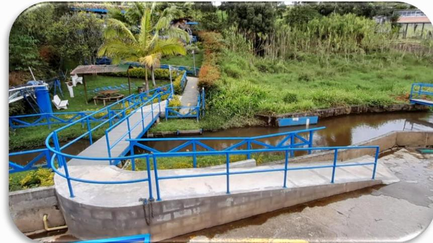
Construcción del puente metálico para el paso a las oficinas sobre la quebrada Cascajo, con la instalación de una rampa para facilitar el acceso a personas en condición de discapacidad.
