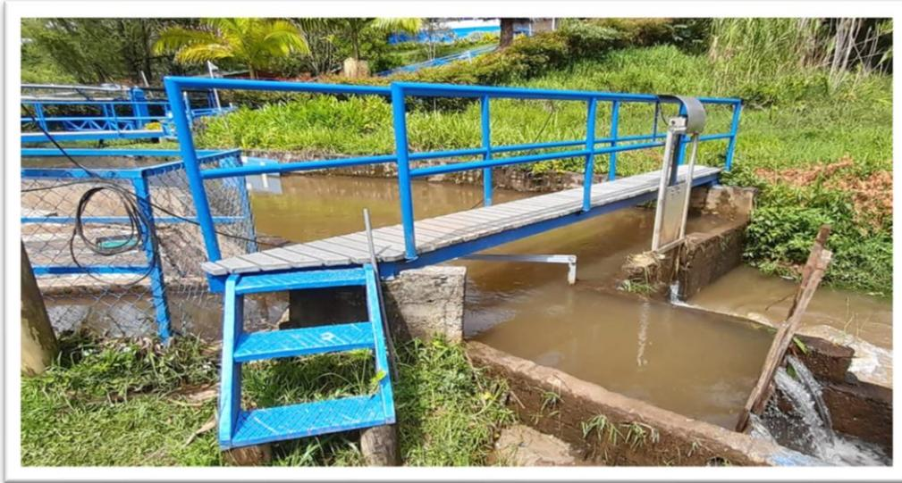
Puente metálico para operación y mantenimiento de la compuerta de control de la Bocatoma del Acueducto.
